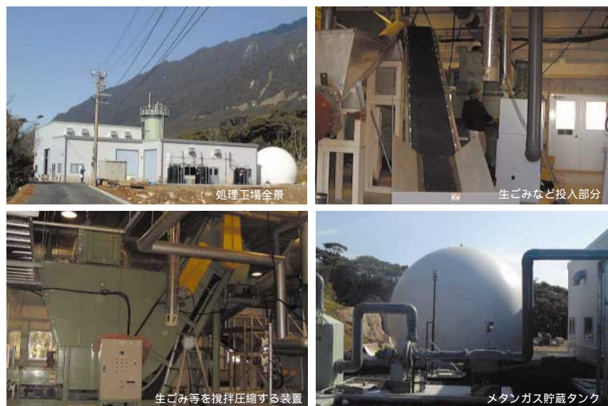
図5 鹿児島大学と自治体、企業と共に設置した有機物系廃棄物（生ゴミなど）からメタンガスを採るパイロットプラント（2001.3）
